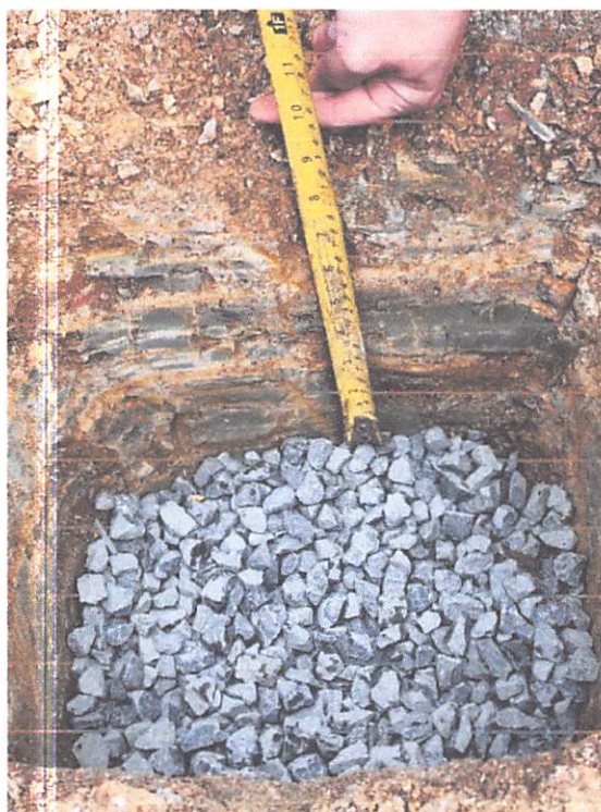
Figura 4 – Conferência da espessura da camada bruta.
